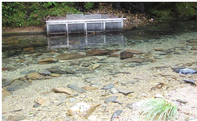
水源地の取水口
